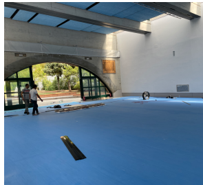
改修工事が進む体育館
